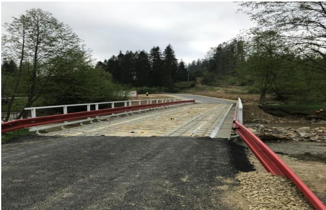
Obrázek 14 – Mostní konstrukce AM-50 Zdroj: MBM – Group a.s.
