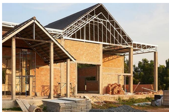
Obrázek 3: Hrubá stavba rodinného domu
