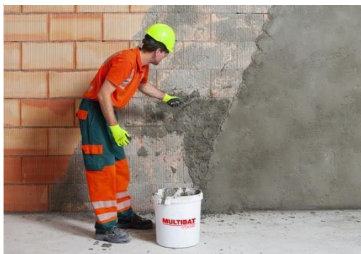
Obrázek 4: Provádění nátěru a omítání svislé konstrukce
