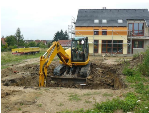
Obrázek 2: Zemní práce, hloubení jamy
