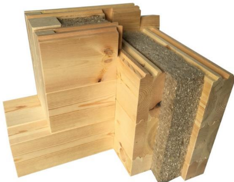
Obrázek 7-Roubená obvodová stěna dvojitá s tepelným izolantem
