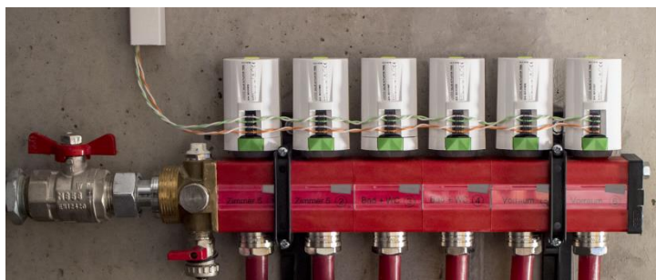
Obrázek 24 Rozdělovač podlahového vytápění s hlavicemi Loxone Tree
