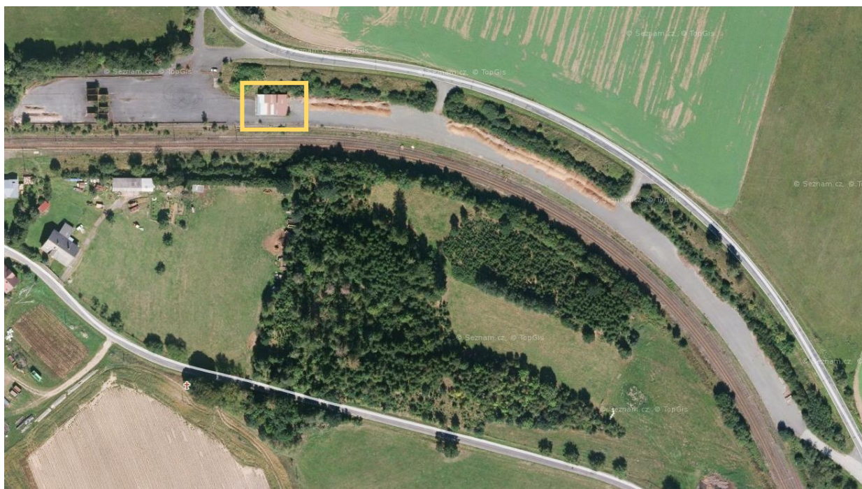
Obrázek 10 – Příklad MNV k okamžitému užití v systému ve stanici Malonice; objekt určen k demolici (žlutě); [27]
