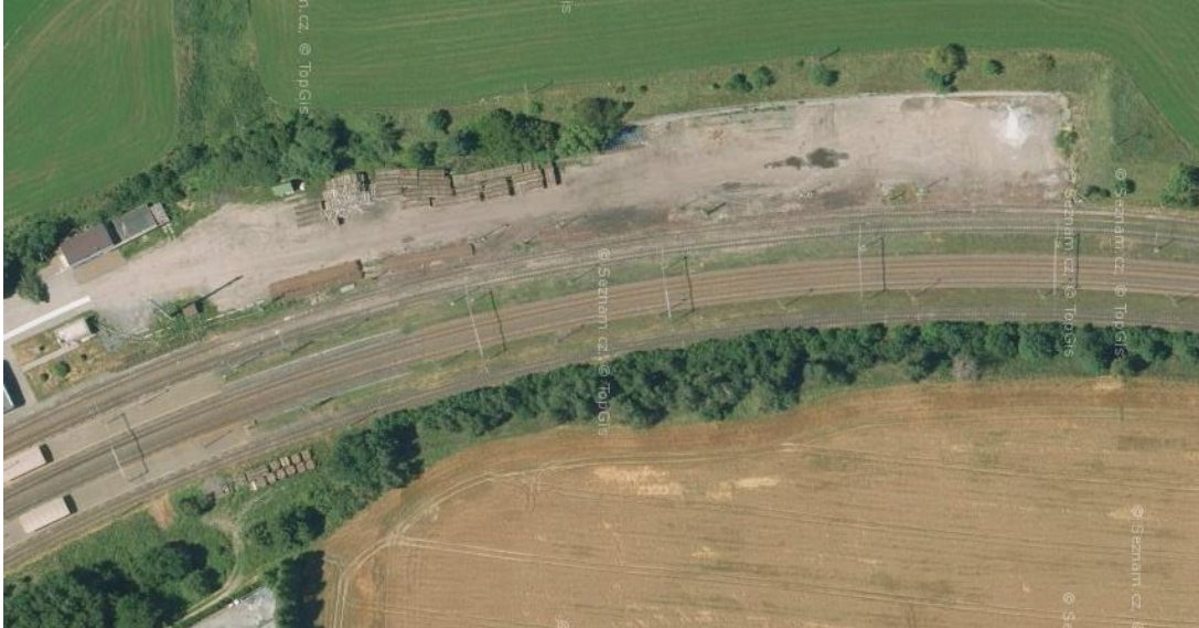
Obrázek 16 - příklad MNV k užití po stavební úpravě ve stanici Ostrov nad Oslavou; [27]
