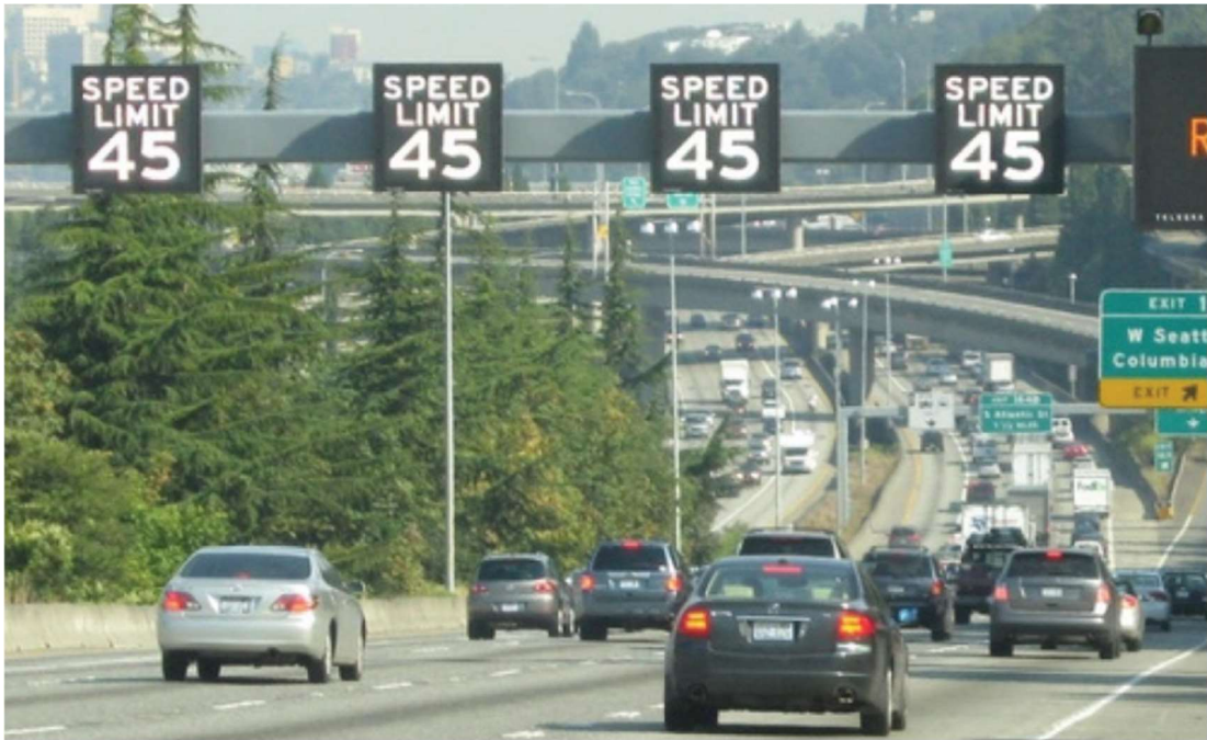
Obrázek 5: Příklad portálu omezující nejvyšší povolenou rychlost v USA [12]
