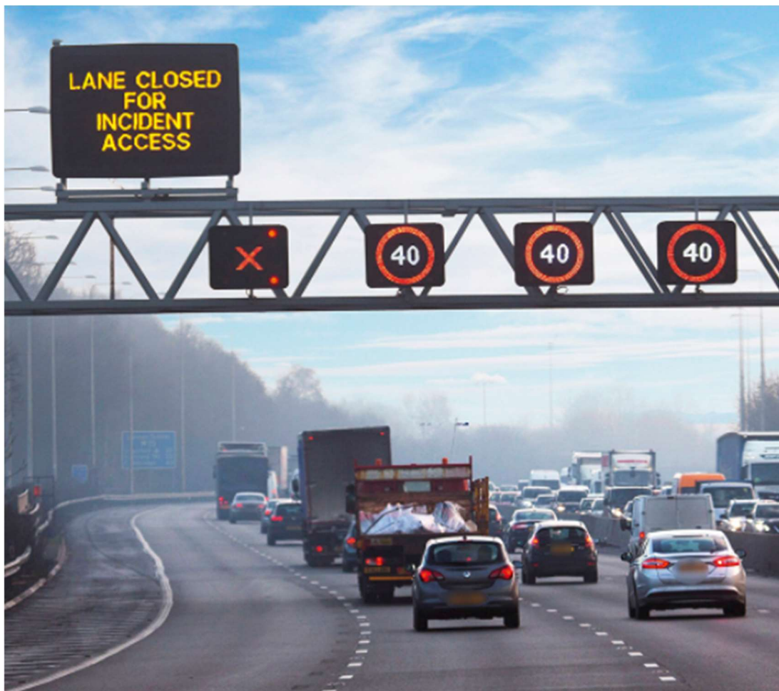
Obrázek 4: Uzavření jízdního pruhu a omezení rychlosti systémem LŘD ve spojeném království [11]
