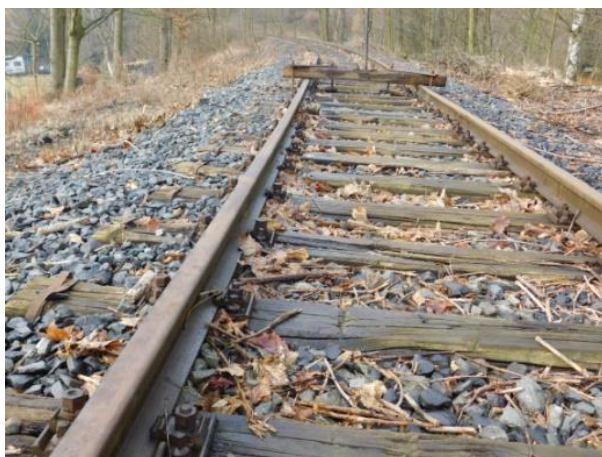
Obrázek 6 - Současný stav tratě za zastávkou Telnice, nesjízdná trasa (zdroj: autor)
