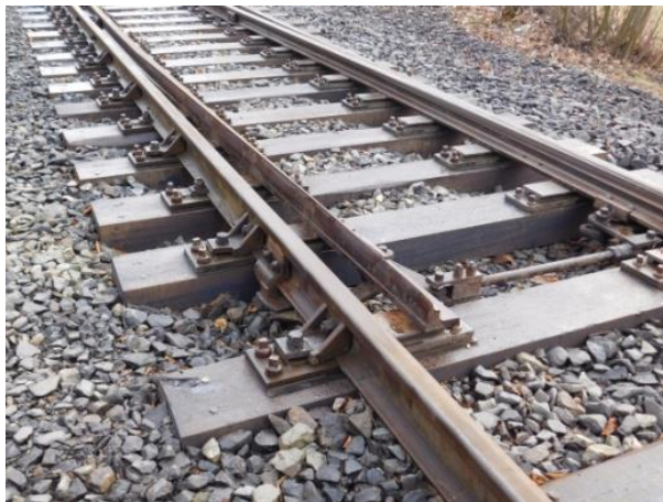
Obrázek 5 - Opravený železniční svršek u zastávky Telnice (zdroj: autor)
