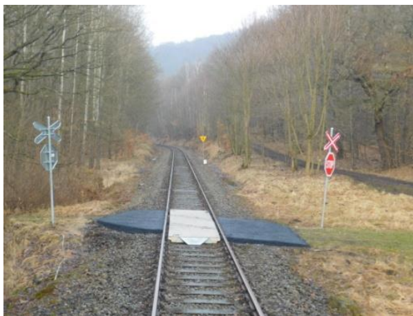
Obrázek 4 - Ukázka opraveného železničního přejezdu před Telnicí (zdroj: autor)
