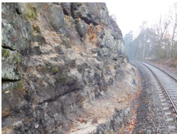
Obrázek 3 - Ukázka skalního masivu nedaleko Oldřichova u Děčína po provedených opravných prací (zdroj: autor)
