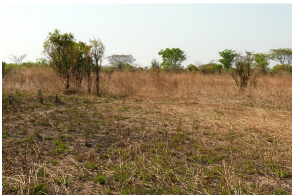
Obr. 48 Miesto stavby, foto. z Archívu realizačného tímu 2018
