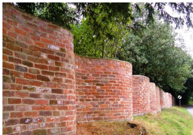
Obr. 53 Zvltný múr z podhľadu, zdroj https://bit.ly/3MvnDww
