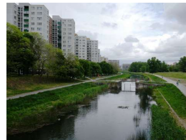
Kanál Chorvátske rameno. Zdroj: bratislavaden.sk
