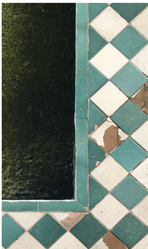
vliv blízkého východu na lázeňskou architekturu v Evropě, Malaga
