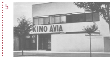
1929 stavba funkcionalistické budovy kino Avia od Josefa Kranze
