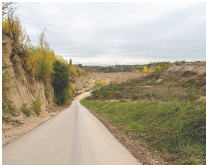
13 _ obslužná komunikace jižní jámy
