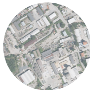
6 roztříštěná zástavba skladovacích a průmyslových hal
