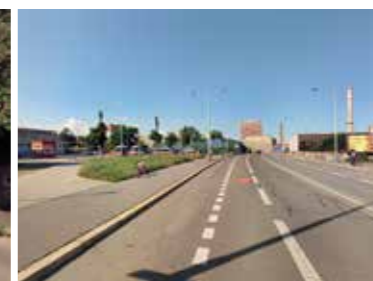
chybějící úrovnový přechod mezi stanicí metra a vlaku, Nádraží Holešovice
