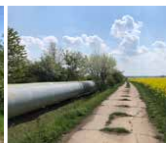
liniový prvek - teplovod s bohatou skladbou doprovodné vegetace, Hovorčovice
