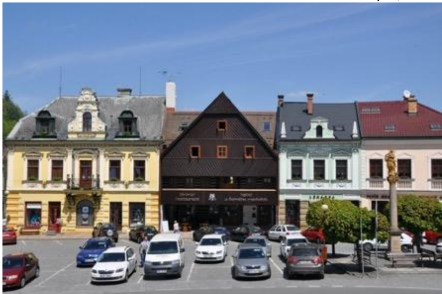
Obrázek 2: Jednopatrový roubený dům s podhoubím a dřevěnou pavlačí z roku 1751 přezdíváný Černý medvěd v kontrastu s okolními budovami a auty na náměstí Jablonného v Orlických horách [foto]. In: Český rozhlas [online]. [cit. 8. 5. 2022]. Dostupné z: https://regiony.rozhlas.cz/namesti-v-jablonnem-nad-orlici-hrozila-demolice-zachranili-ho-nadsenci-v-70-7414532 .
