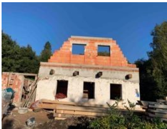
Obrázek 33: Čelní strana chalupy při rekonstrukci.
