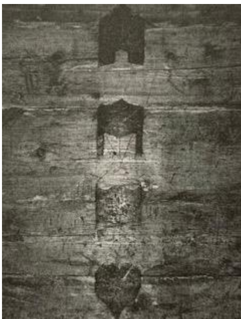
Obrázek 40: Ojedinělý doklad zdobné vazby v místě napojení kolmé vnitřní stěny (Tyrolsko). In: PEŠTA, Jan. Rekonstrukce roubených staveb .
