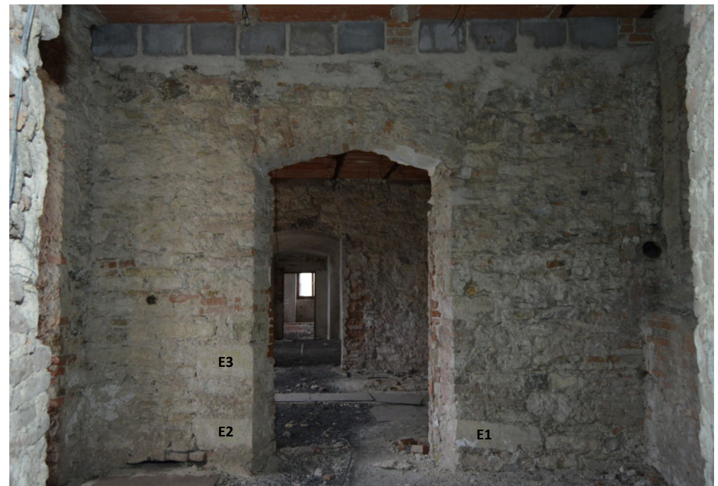
Pohled na severní stěnu místnosti E.
