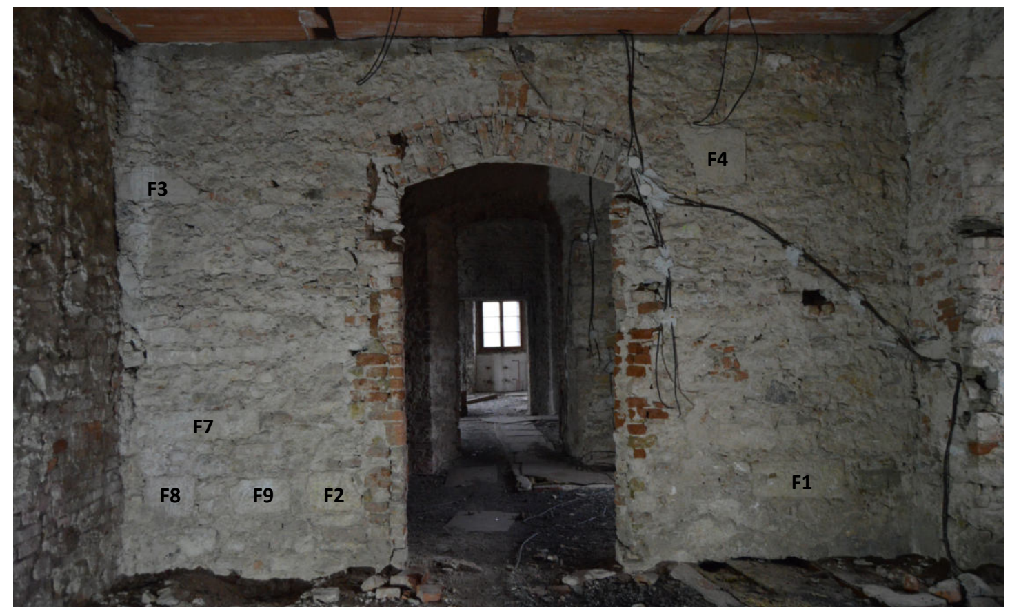
Pohled na sjižní stěnu místnosti F.
