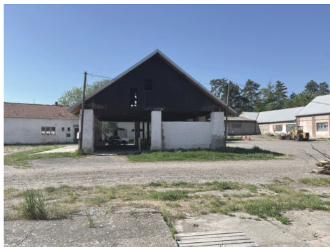
Sloupová stodola s jižní budovou v pozadí.
