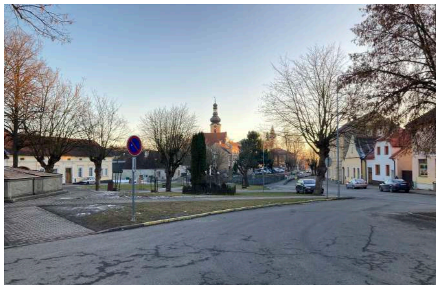
Náměstí Mírně se rozšiřující trojúhelníkového náměstí. Domy jsou zde orientovány svými hřebeny rovnoběžně s uličním profilem.
