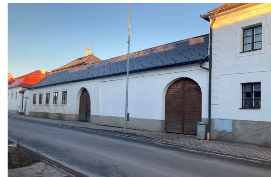
Městský dům č.p. 34 Dům byl datován na 19. stol. Nebyl zásadně přestavován, úpravy byly pouze drobného charakteru, jako např. výměna dvou výplní oken.
