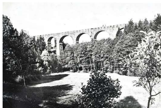
Chýnovský železniční viadukt
