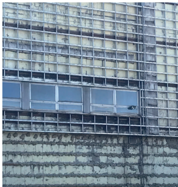
uchytenie obkladu na rošte - vo dvore
