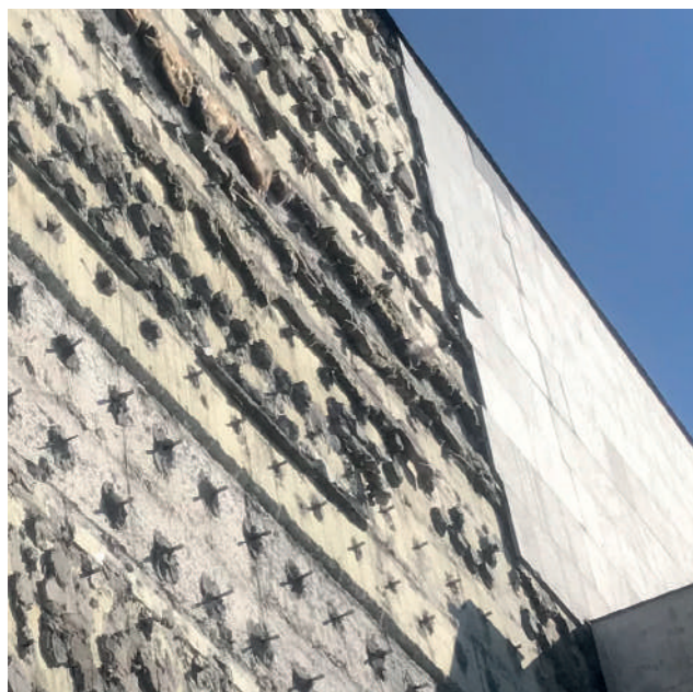
spôsob uchytenia obkladu - kovové háky a lepiaca hmota
