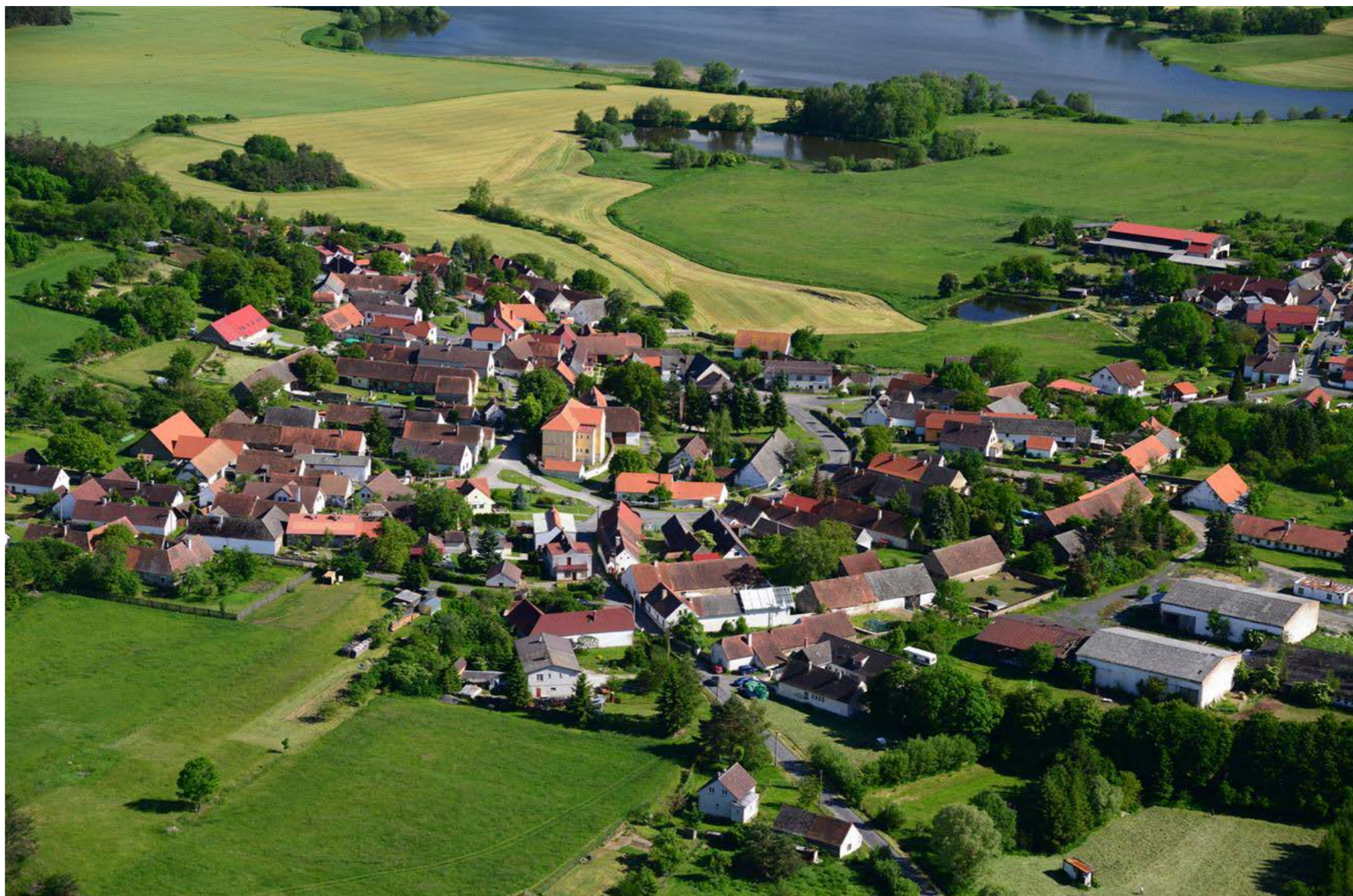
současný snímek vesnice ze severu – střešní krajina (18)
