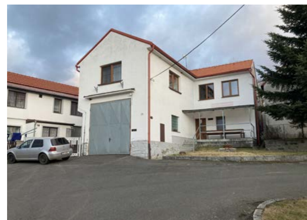
celkový pohled na hasičárnu
