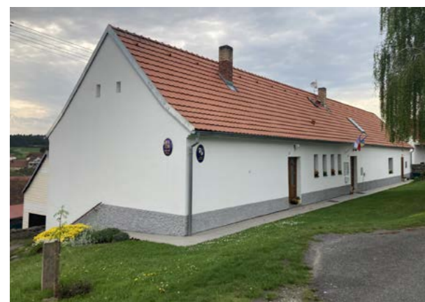
vstup do OÚ
