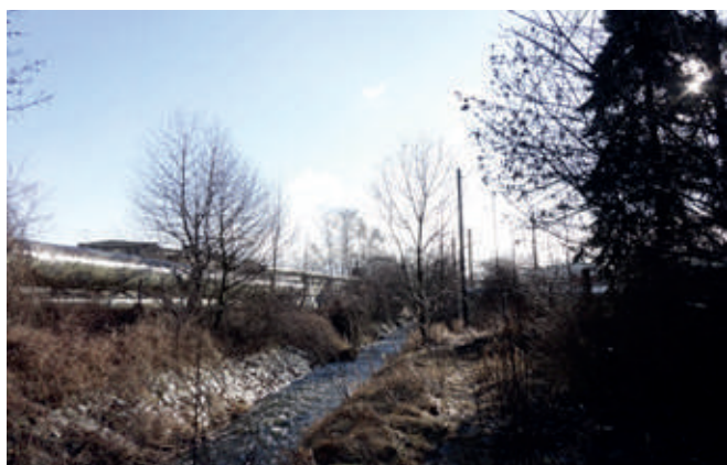
Obr. 24 – Divoký úsek před vstupem do průmyslových areálů
