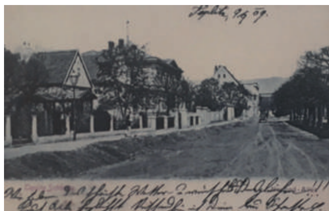
Obr. 52 – V roce 1910 probíhala v ulici U Nových lázní regulace potoka Bystřice, při které bylo koryto prohloubeno a zakryto
