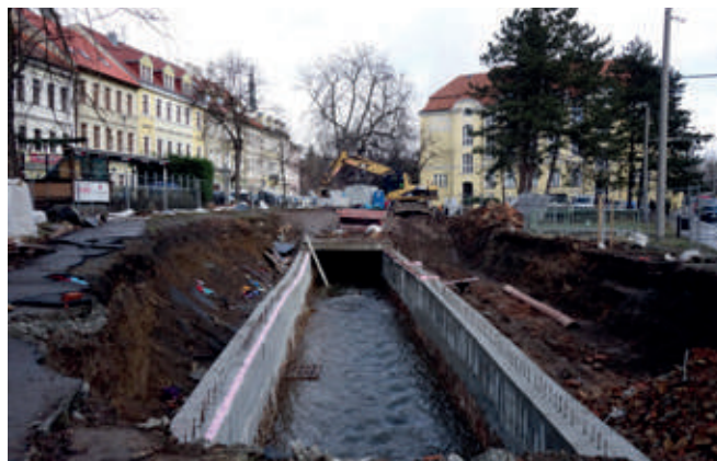
Obr. 17 – Nahrazení klenby železobetonovou konstrukcí v Humboldtových sadech
