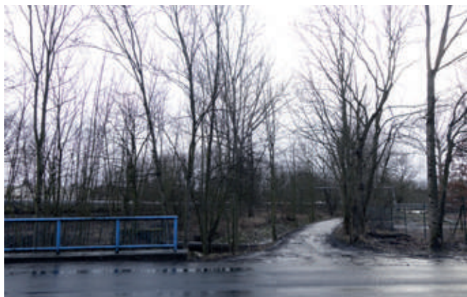
Obr. 19 – Počátek úseku u silničního mostu
