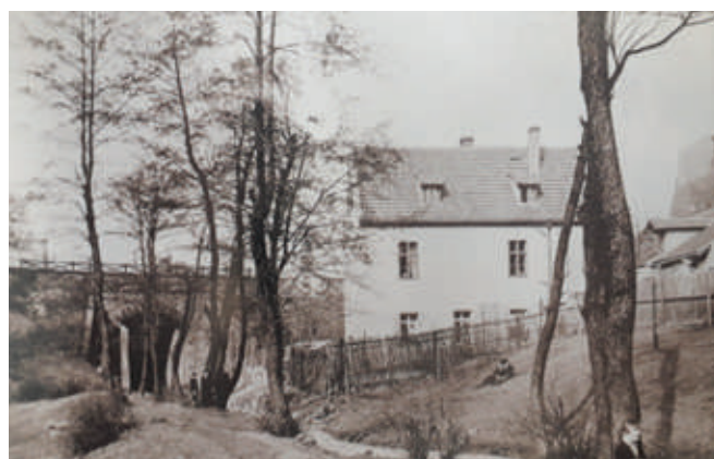
Obr. 92 – Domek č. p. 279 na území dnešního areálu ČEZ u břehu Sviního potoka, v pozadí viadukt u Hornické ulice
