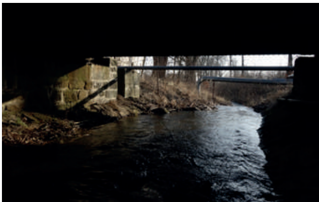
Obr. 76 – Vyústění z výrobního areálu směrem do lesa
