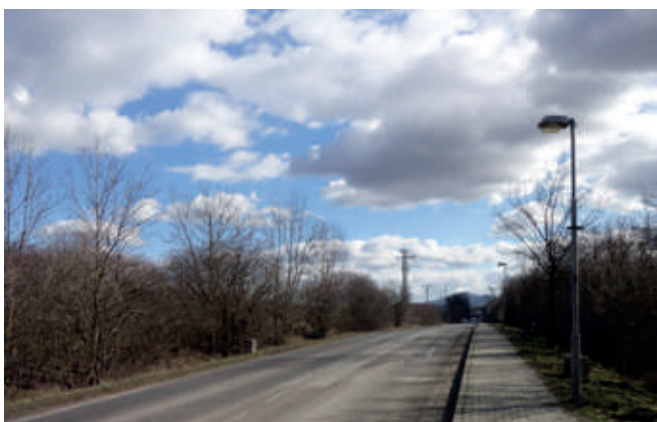
Obr. 69 – Ulice Pražská, pěší spojení Teplic a Bystřan
