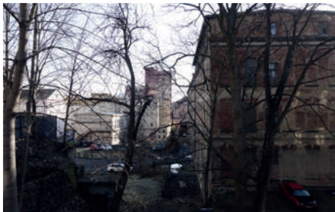
Obr. 105 – Pohled od vnitrobloku teréně položeného cca o 5 metrů níže, na jehož dně se nachází strop Sviního potoka
