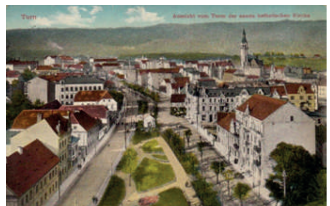
Obr. 34 – Výhled z věže Červeného kostela, uprostřed malé náměstíčko s kaplí sv. Rocha, r. 1913
