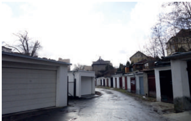
Obr. 47 – Slepá ulice s garážemi na počátku úseku
