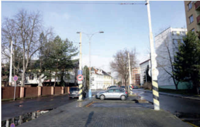
Obr. 29 – Zakryté koryto je využíváno jako parkoviště
