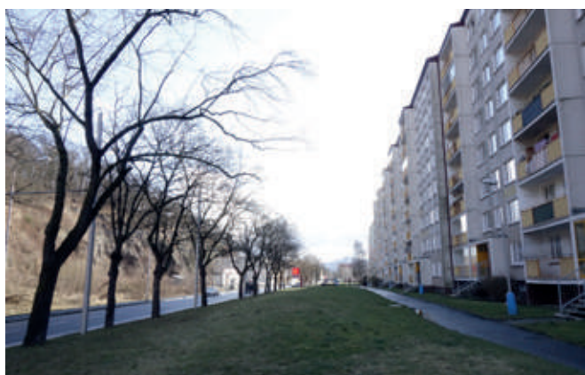
Obr. 61 – Nevyužívaná zatravněná plocha, pod kterou protéká Bystřice
