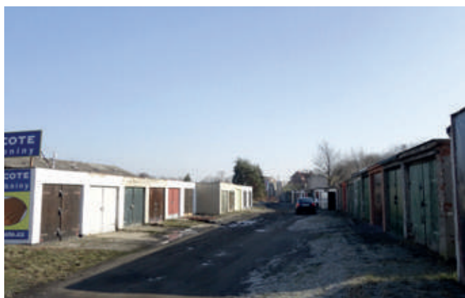
Obr. 88 – Sviní potok zde prochází přímo mezi garážemi
