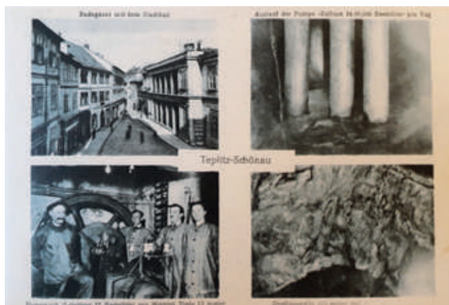
Obr. 10 – Zřídelní šachta Pravřídla, r. 1912
