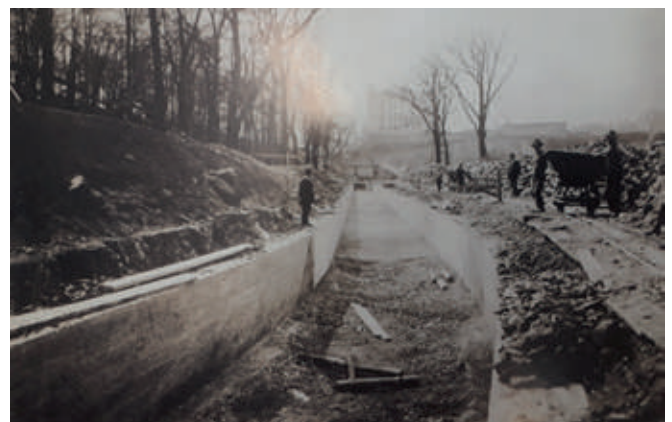
Obr. 45 – Zakrývání potoka Bystřice betonovými panely
