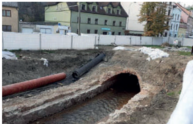
Obr. 15 – Oprava koryta v Humboldtových sadech, r. 2021
