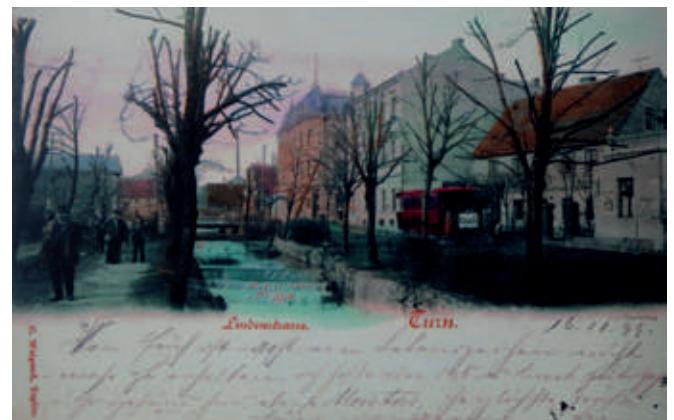
Obr. 33 – Nezakryté koryto Bystřice s umělými kaskádami cca v roce 1899, v pozadí domy zbořené v letech 1985 až 1988 18
