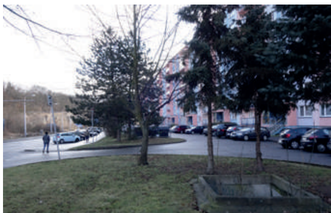
Obr. 60 – Kontrolní šachta Bystřice vedoucí pod parkovištěm
