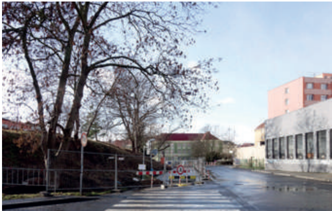
Obr. 41 – Koryto v ulici Palackého
