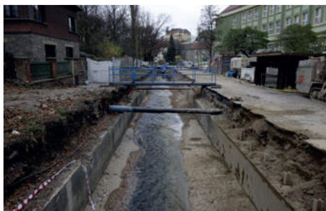
Obr. 16 – Probíhající rekonstrukce koryta Bystřice v Palackého ulici u ZŠ Metelkovo náměstí
