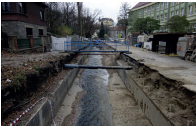
Obr. 42 – Probíhající renovace zakrytí v ulici Palackého
