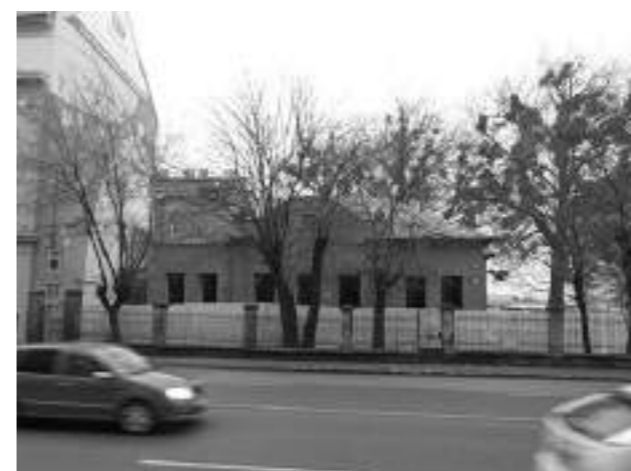
Parcela pred demoláciou budovy z Palackého ulice
