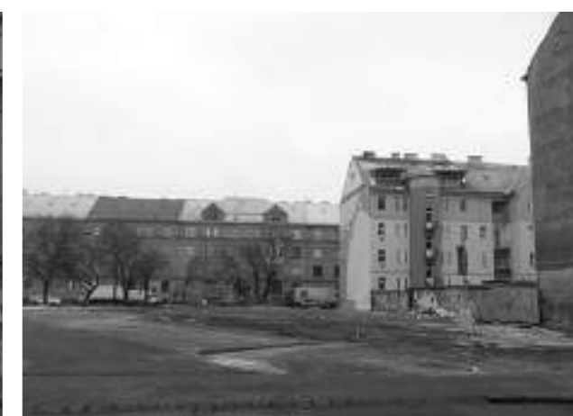
Parcela po demolácii budovy z Bajzovej ulice
