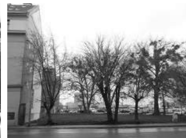
Parcela po demolácii budovy s ešte stojacimi stromami
