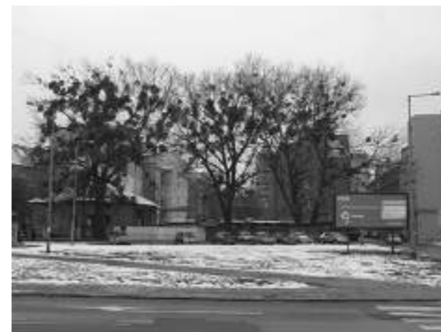
Parcela pred demoláciou budovy
