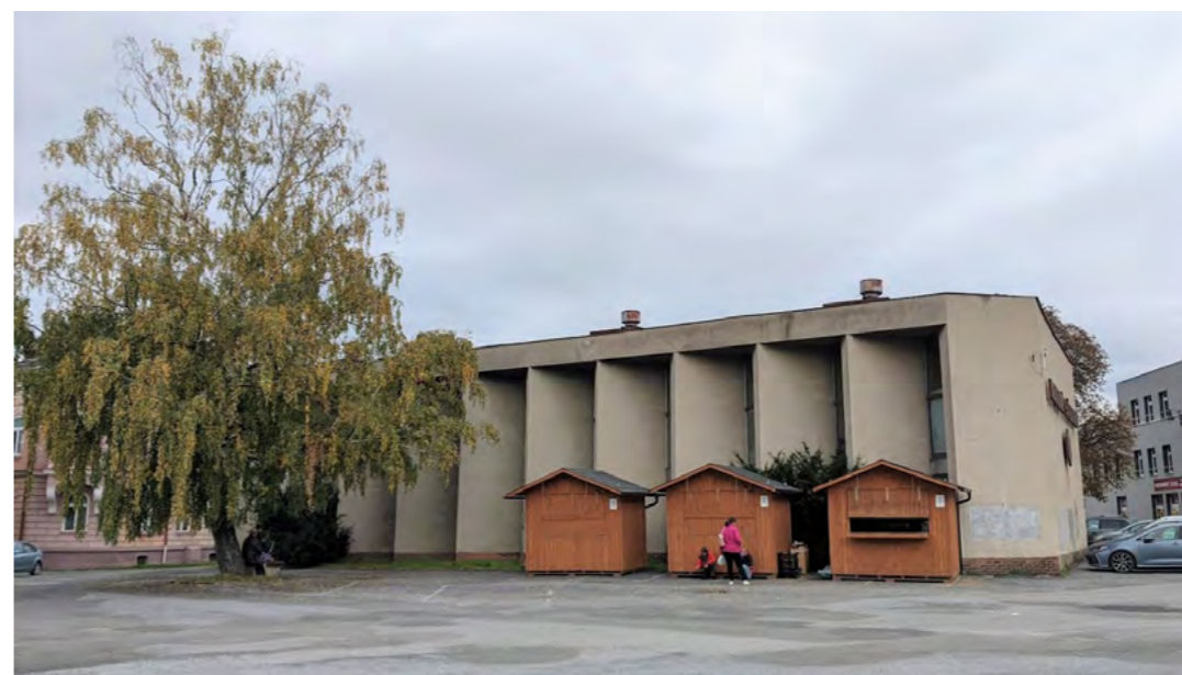
Dominantní budova před vstupem na náměstí. Kulturní středisko, jež bylo využíváno jako hotel s kulturním sálem. Dnes se v dochovaném sále nachází vietnamská tržnice.
