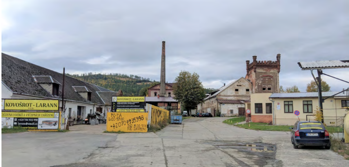
Pohled na bývalý zámecký pivovar z hlavní silnice
