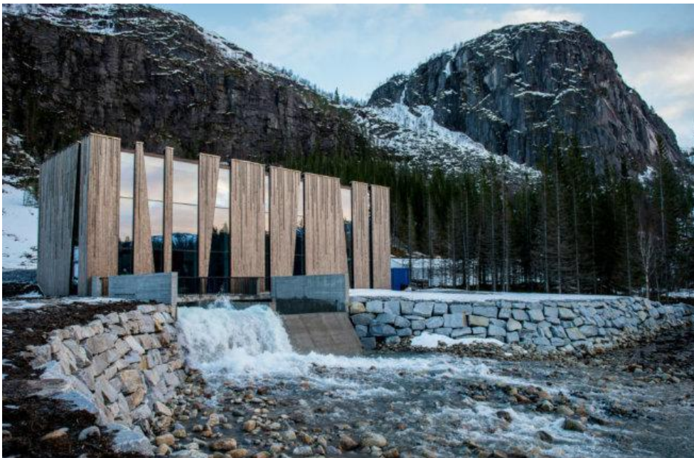
Obrázek 8 - Hydroelektrárna v Norsku
