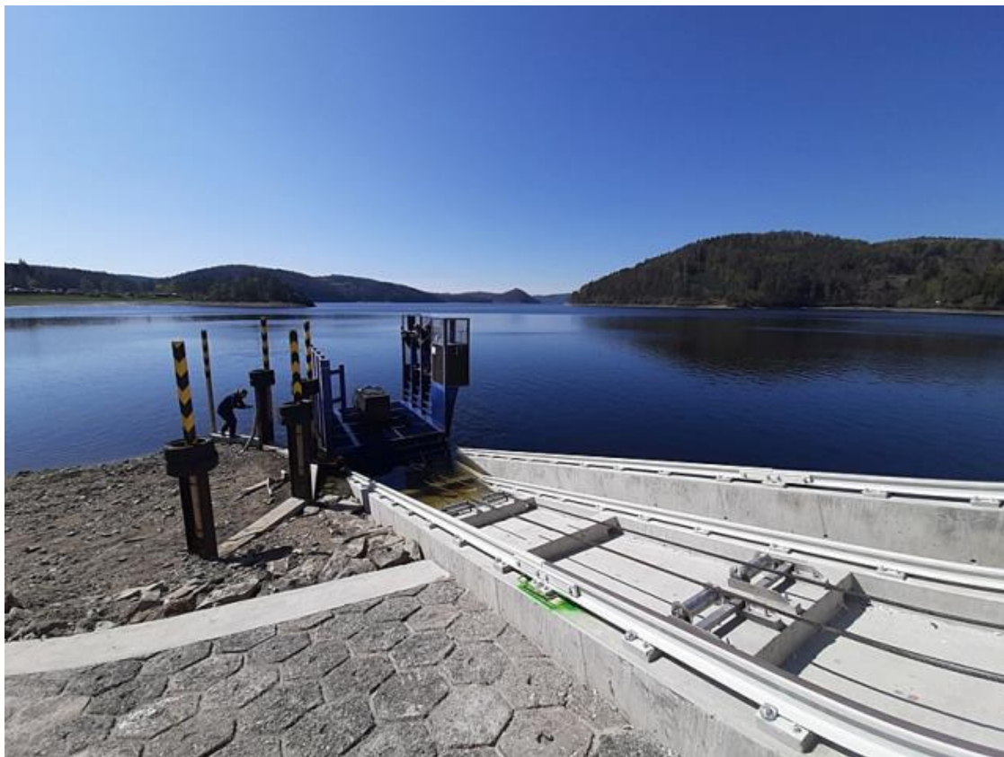
Obr. 6.1: Modernizovaný lodní výtah na návodní straně hráze VD Orlik 28
