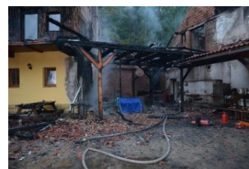
stav objektu v době lokalizace – pohled na středovou část
