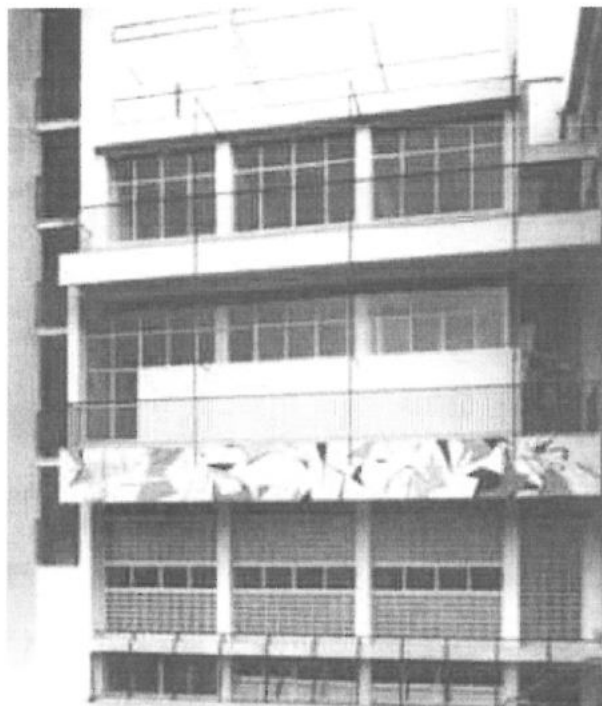
Malby na vstupním průčelí a ve vstupní hale soukromé školy Miláně, Itálie. Autoři: Carlo Slama a Ibrahim Kodra, architekt: Carlo Slama
