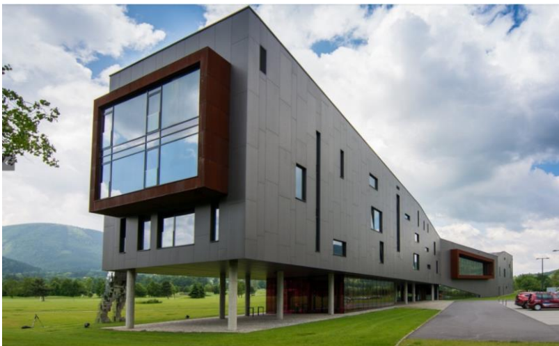
Obr.1 - Příklad referenční fasády dvouplášťové konstrukce s větranou mezerou a s obkladem z vláknocementových desek Cembrit Solid - Hotel Miura, Čeladná.
