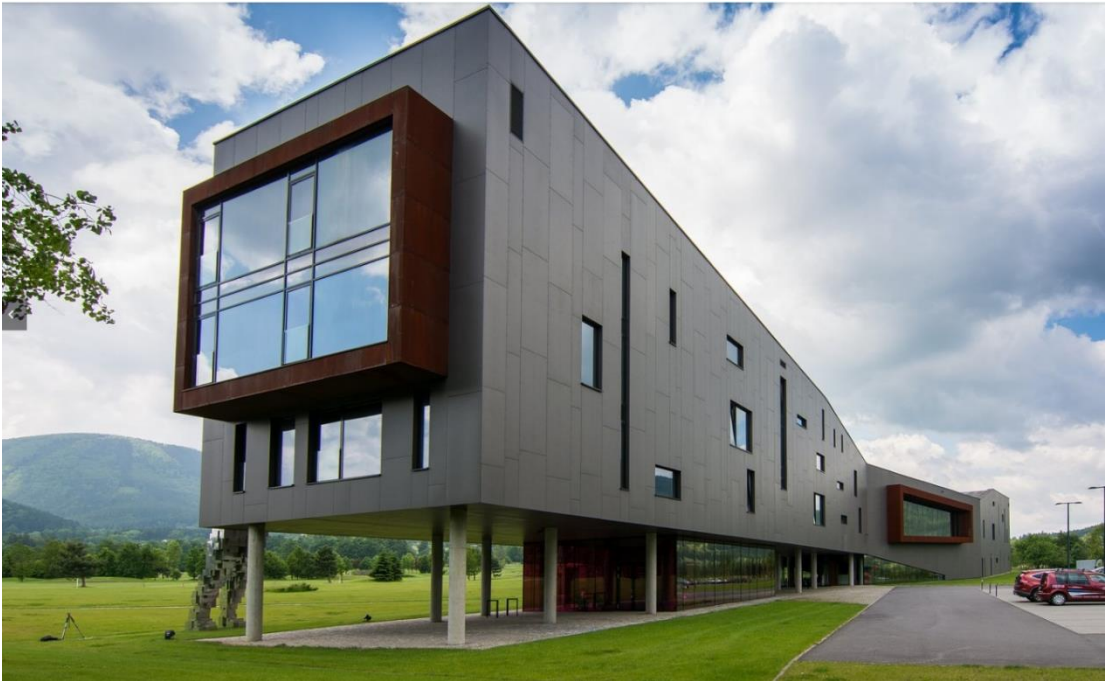
Obr. 24 - Příklad referenční fasády - dvouplášťová konstrukce s větranou mezerou a s obkladem z vláknocementových desek Cembrit Solid - Hotel Miura, Čeladná. Zdroj: fotoarchiv autora.
