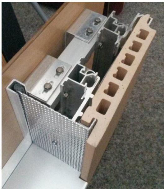
Obr. 14 - Masivní podkonstrukce keramického obkladu Möding Alphaton s výrazným vlivem systémových tepelných mostů
