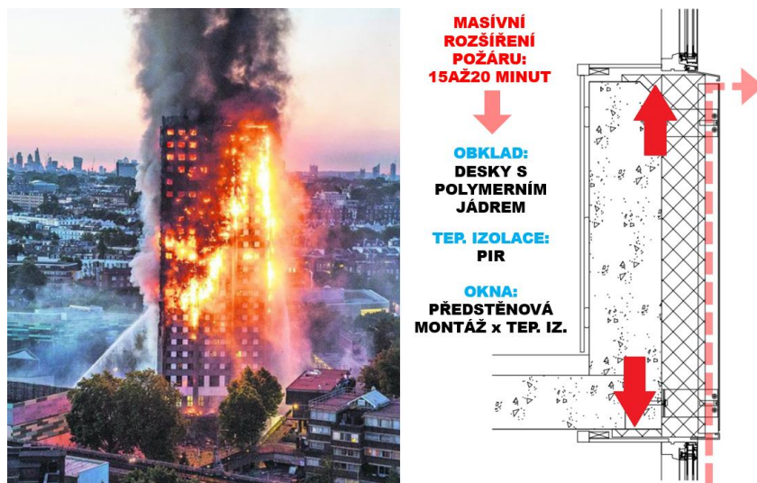
Obr. 18 - Požár Grenfell Tower - Londýn Kensington, červen 2017. 79 obětí. Konstrukce fasády s větranou mezerou, použití obkladových desek s polymerním jádrem, materiál tepelné izolace PIR, nevhodné konstrukční řešení předstěnové montáže oken. Zdroj: POKORNÝ 2017. https://www.tzb-info.cz/pozarni-bezpecnost-staveb/15920-mozne-priciny-vzniku-a-sireni-pozaru-v-bytovem-dome-grenfell-tower-v-londyne
