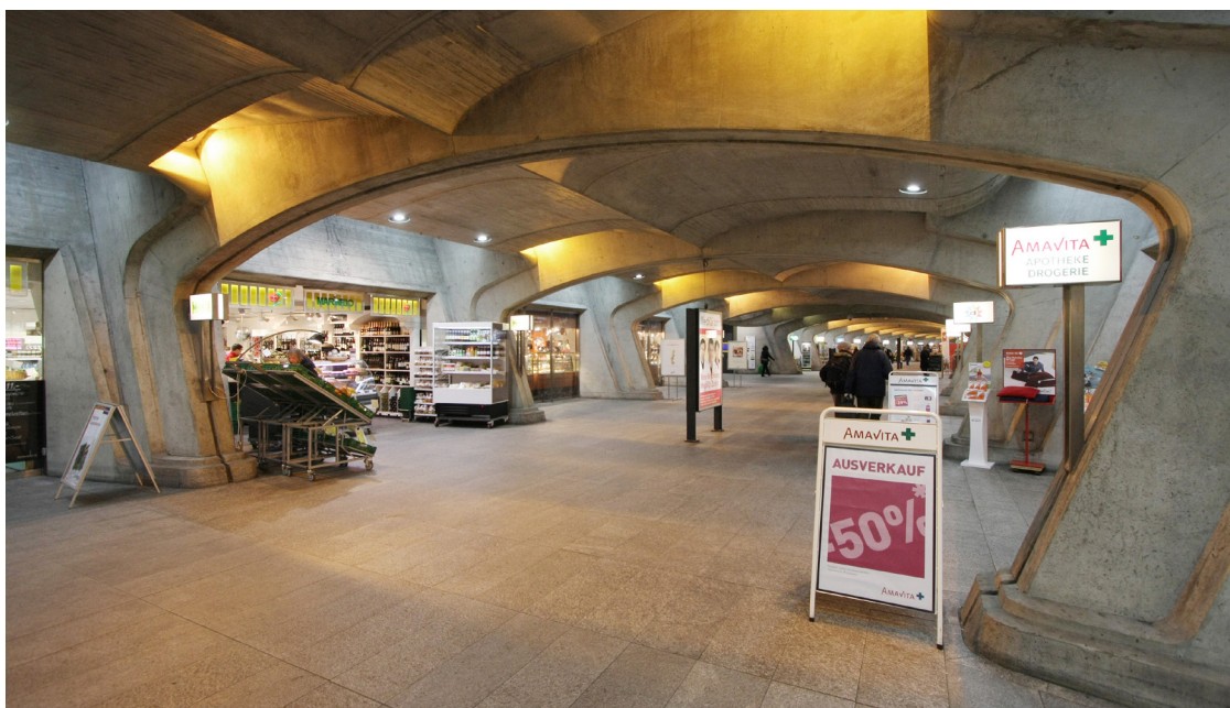
Obrázek 47: Barevné nasvícení betonových nosníků v kombinaci s denním světlem (Stadelhofen, Zurich, Švýcarsko)
