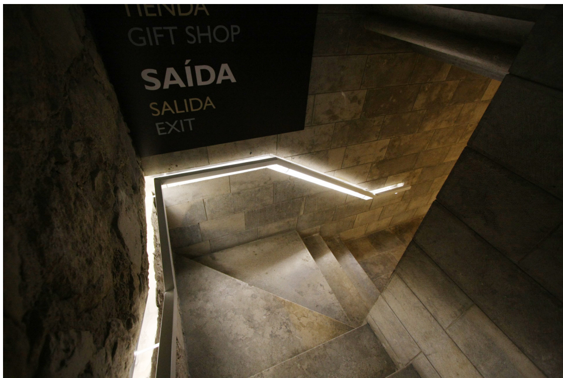
Obrázek 63: Světelný prvek - schodišťové madlo (Castelo de S. Jorge, Lisabon, Portugalsko)
