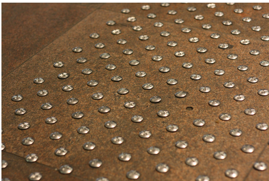
Obrázek 36: Kovové vystupující prvky mohou tvořit dostatečný kontrast s podkladem a mohou být dodatečně kotveny do historické dlažby (Stanice metra, Brusel, Belgie)
