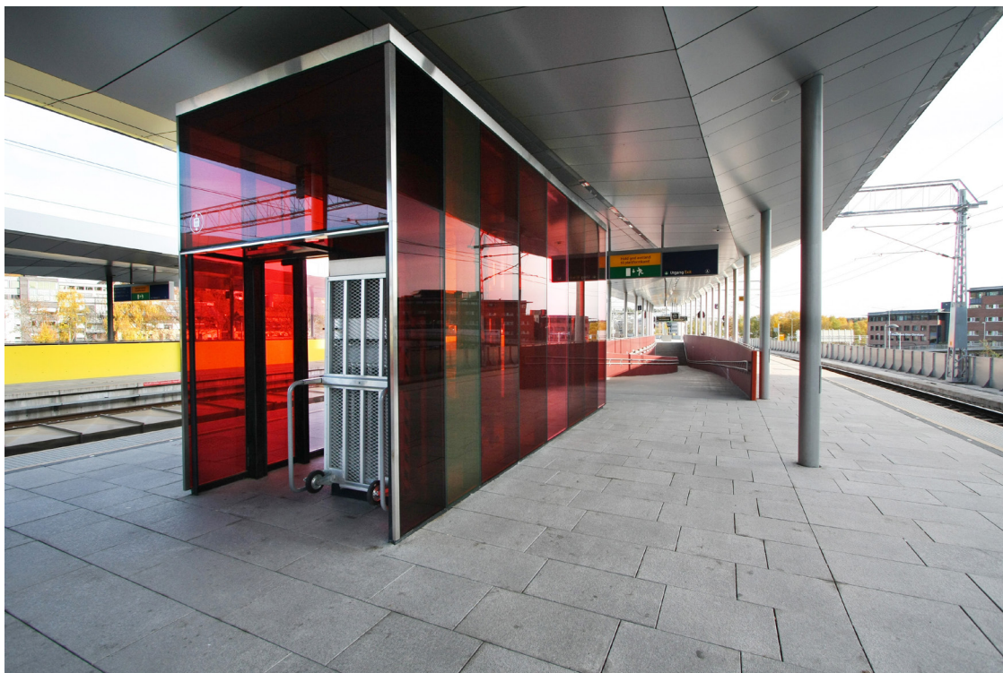
Obrázek 72: Zviditelnění skleněných konstrukcí potiskem barvou (Lysaker station, Oslo, Norsko)
