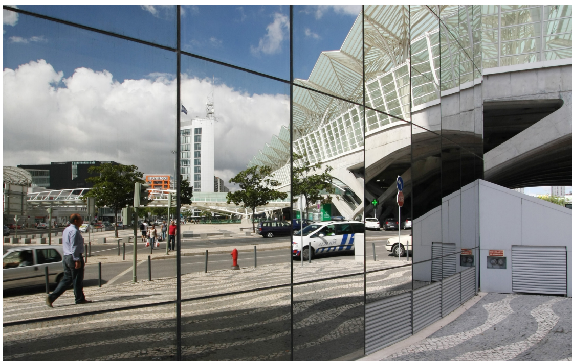
Obrázek 68: Problematické odrazy skleněných konstrukcí (Avenida do Berlim, Lisabon, Portugalsko)
