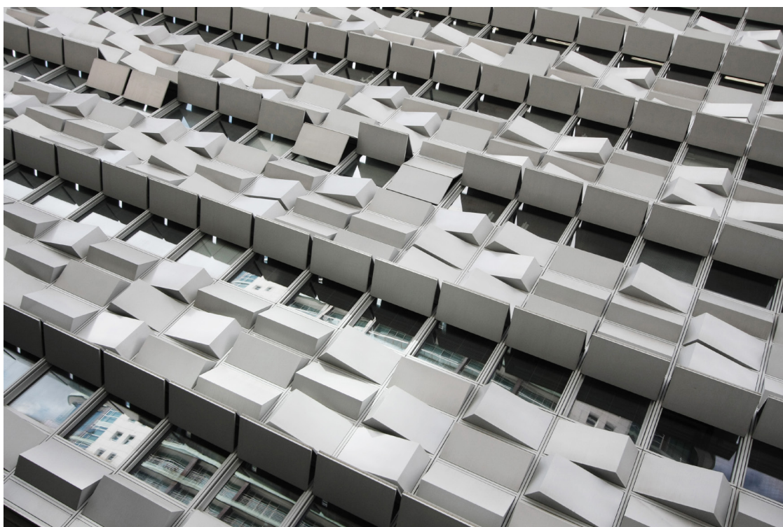
Obrázek 35: Reliéfní prvky pojednávající parapet jsou takového měřítka, že jsou vnímány jako samostatné plastiky a boří tak vnímání členění budovy (Avenida do Indico, Lisabon, Portugalsko)
