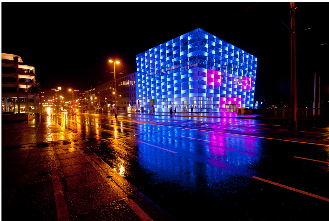
Obrázek 61: Světelný prvek - fasáda budovy (Ars Electronica Center, Linz, Rakousko)
