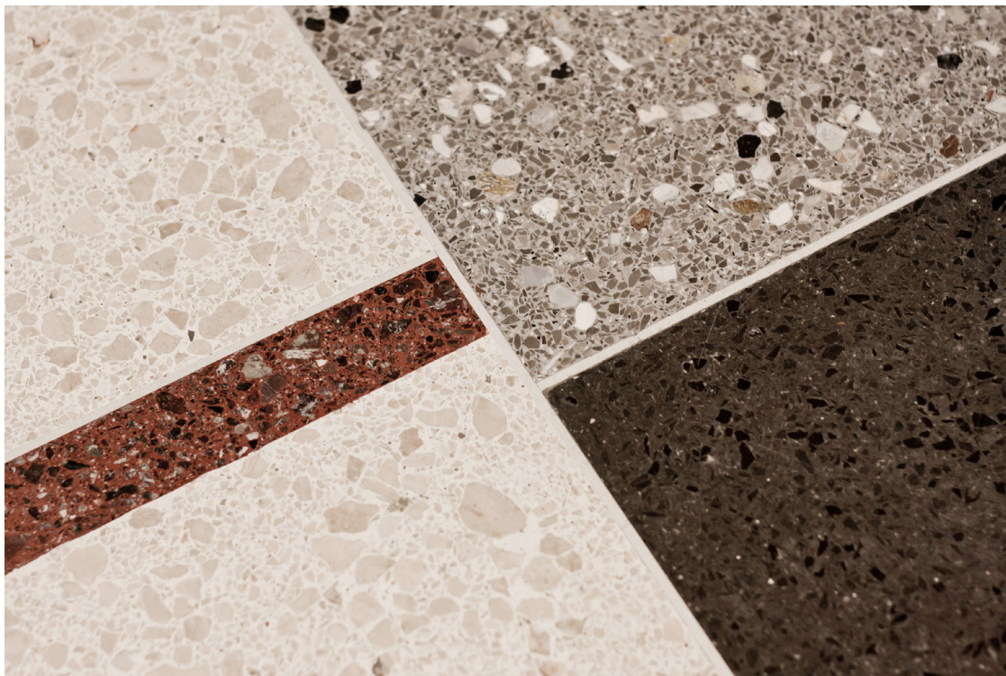
Obrázek 44: Různá pigmentace kamene a pojiva vytváří unikátní povrch (Ernst Koref Schule, Linz, Rakousko)
