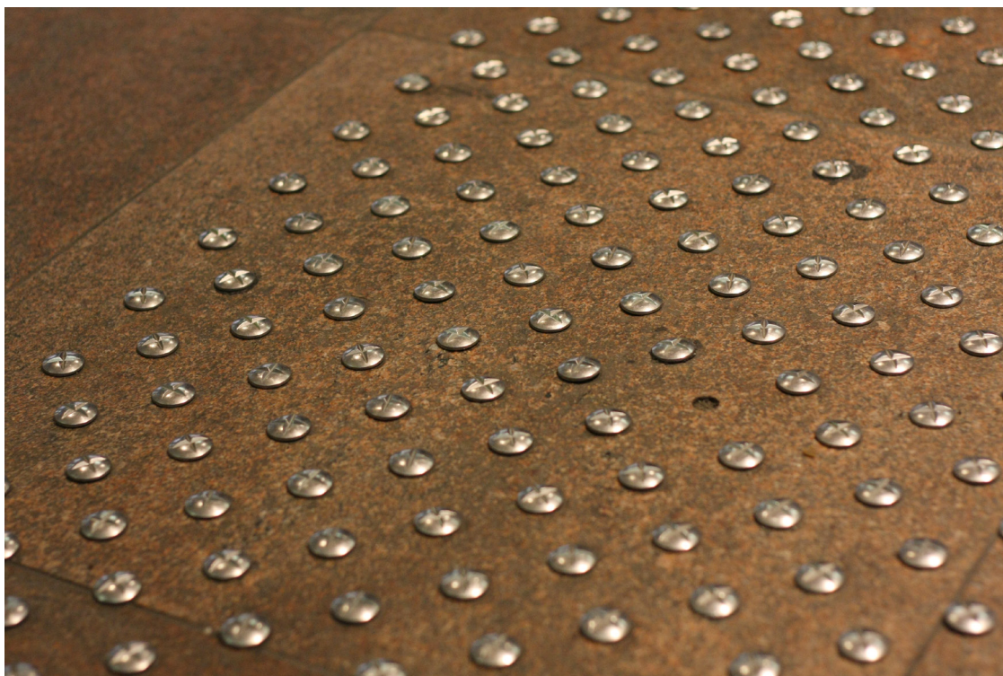
Obrázek 50: Kovové vystupující prvky mohou tvořit dostatečný kontrast s podkladem a mohou být dodatečně kotveny do historické dlažby (Stanice metra, Brusel, Belgie)
