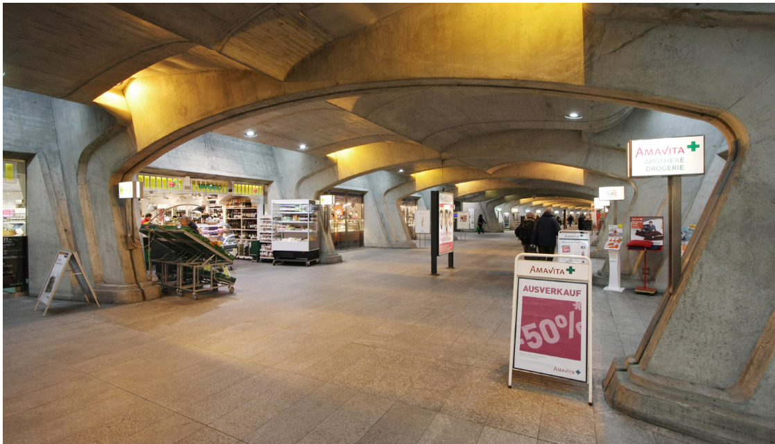
Obrázek 67: Barevné nasvícení betonových nosníků v kombinaci s denním světlem (Stadelhofen, Zurich, Švýcarsko)
