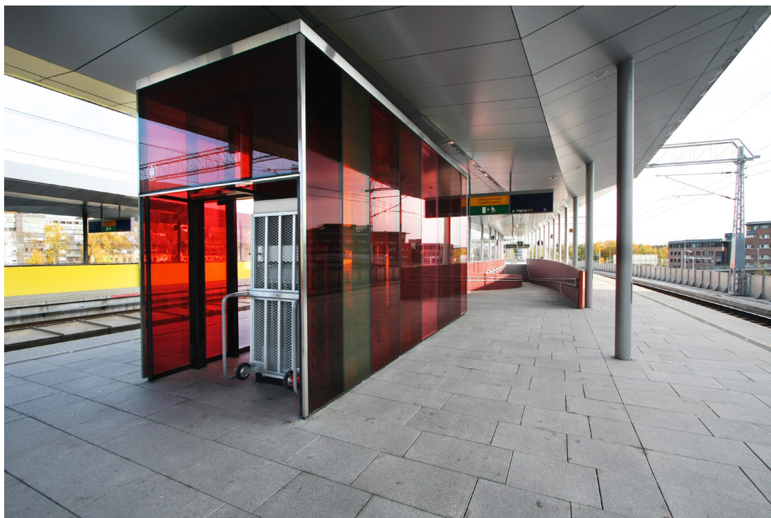
Obrázek 102: Zviditelnění skleněných konstrukcí potiskem barvou (Lysaker station, Oslo, Norsko)
