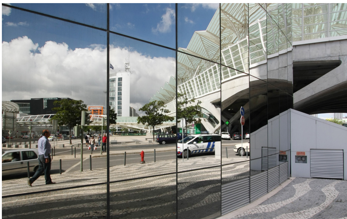
Obrázek 96: Problematické odrazy skleněných konstrukcí (Avenida do Berlim, Lisabon, Portugalsko)
