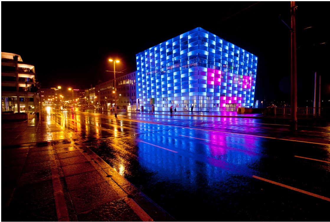
Obrázek 85: Světelný prvek - fasáda budovy (Ars Electronica Center, Linz, Rakousko)
