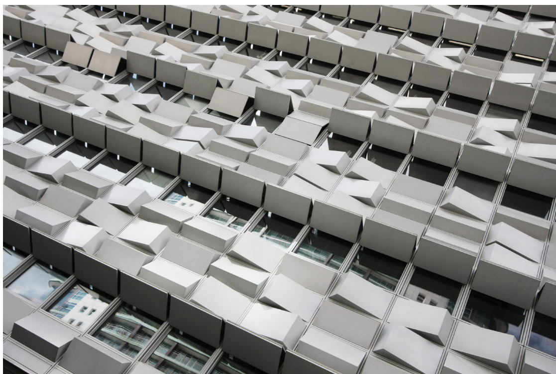
Obrázek 49: Reliéfní prvky pojednávající parapet jsou takového měřítka, že jsou vnímány jako samostatné plastiky a boří tak vnímání členění budovy (Avenida do Indico, Lisabon, Portugalsko)
