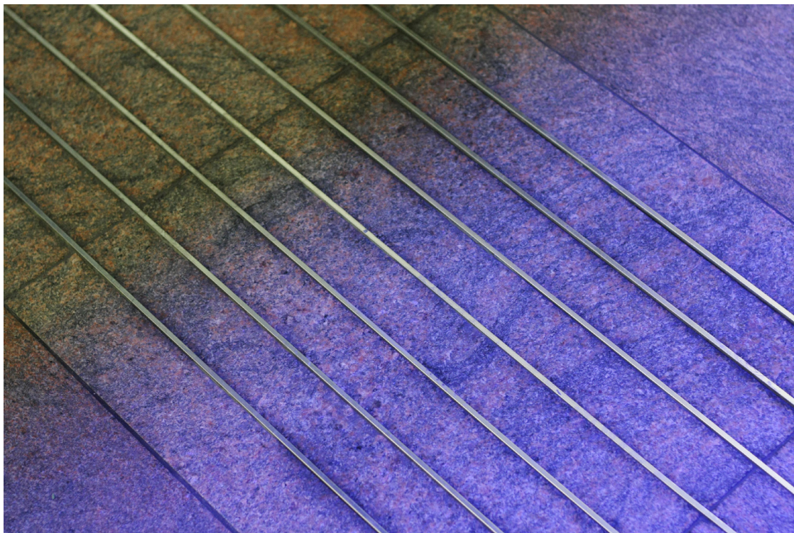
Obrázek 51: Kovové vystupující prvky mohou tvořit dostatečný kontrast s podkladem (Stanice metra, Brusel, Belgie)
