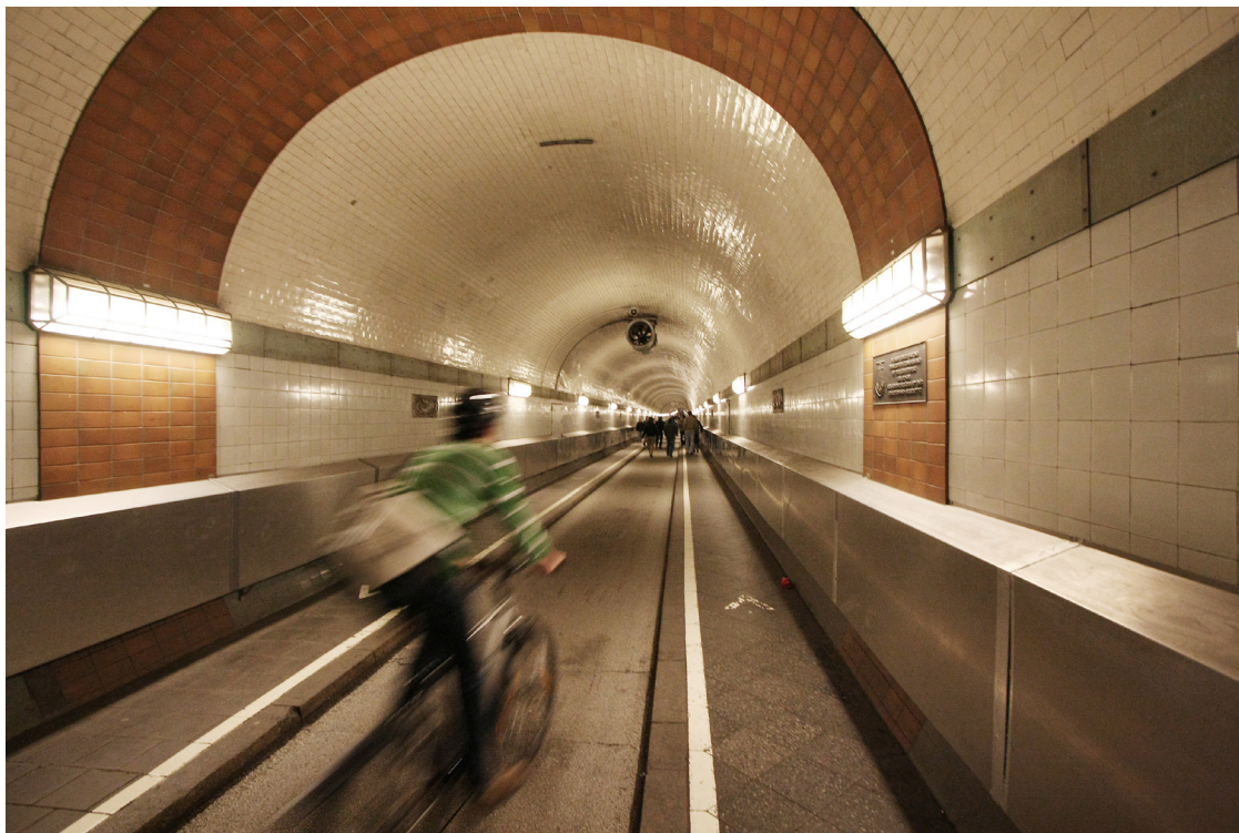
Obrázek 94: Bodové nasvícení prostoru a použití materiálu s odrazivostí vede ke zneřehlednění prostoru a k obtížnější identifikaci jednotlivých prvků a konstrukcí (Hamburg, Německo)
