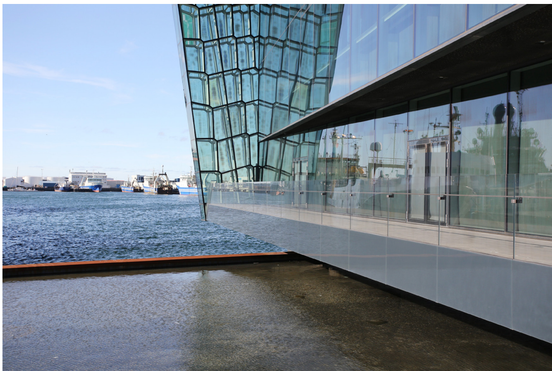
Obrázek 101: Nesnadné vnímání prostoru vymezeného skleněnými konstrukcemi (Budova opery, Reykjavik, Island)
