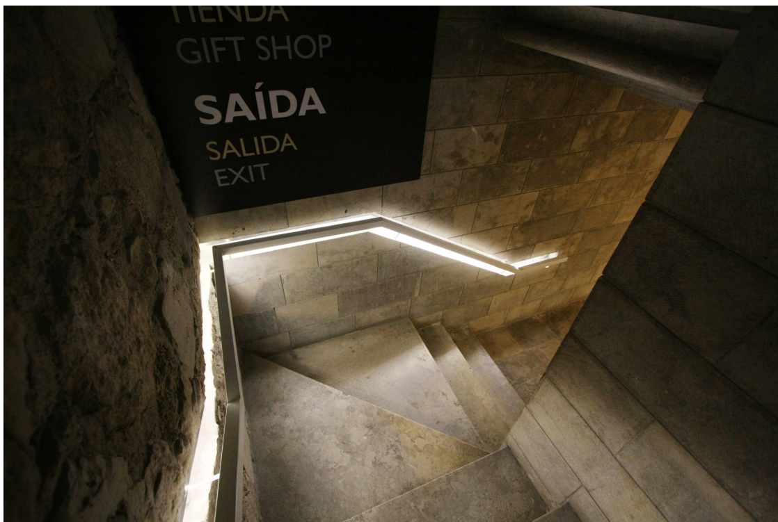
Obrázek 90: Světelný prvek - schodišťové madlo (Castelo de S. Jorge, Lisabon, Portugalsko)
