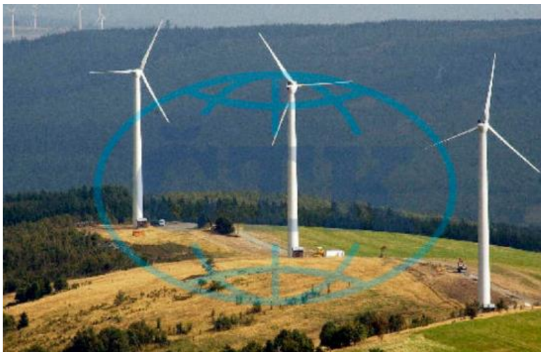
Obr. 6. Trojice větrných elektráren obce Loučná nad Klínovcem v Krušných horách; převzato z [128].
