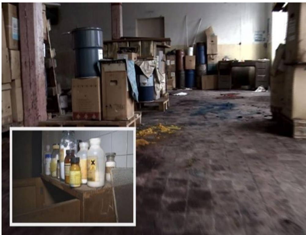
Obr. 17. Sklad nebezpečných látek a podlaha kontaminovaná vylitými kapalnými nebezpečnými látkami [96].
