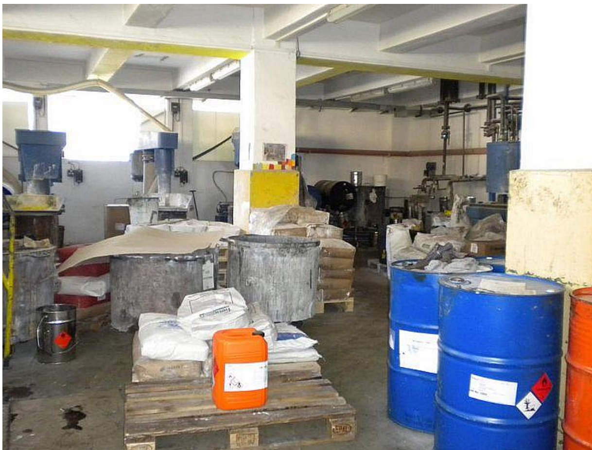
Obr. 25. Příprava sanace prostoru „navažovny“ [126].
