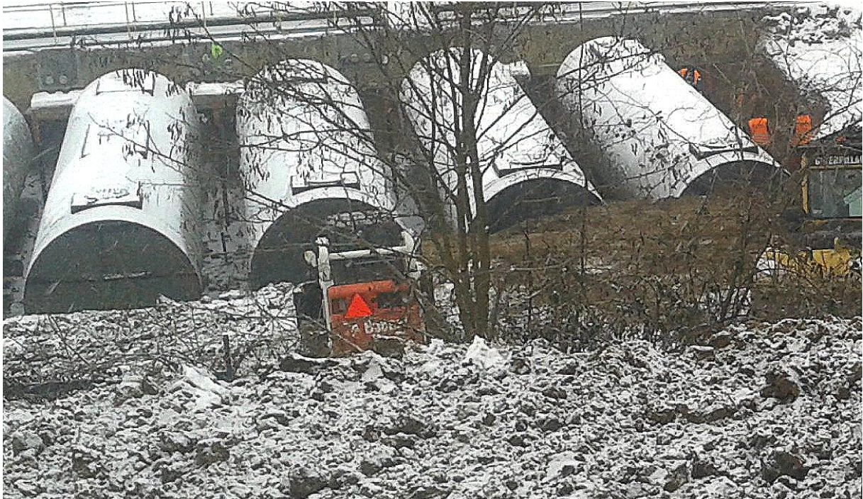
Obr. 24. Příprava demolice a sanace kontaminované zeminy podzemního úložiště kapalných surovin [125].
