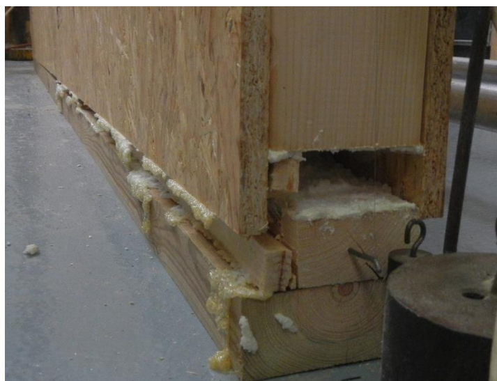
Obr. 59 Porušení spodního lemovacího prvku v tahu kolmo na vlákna a OSB pláště
